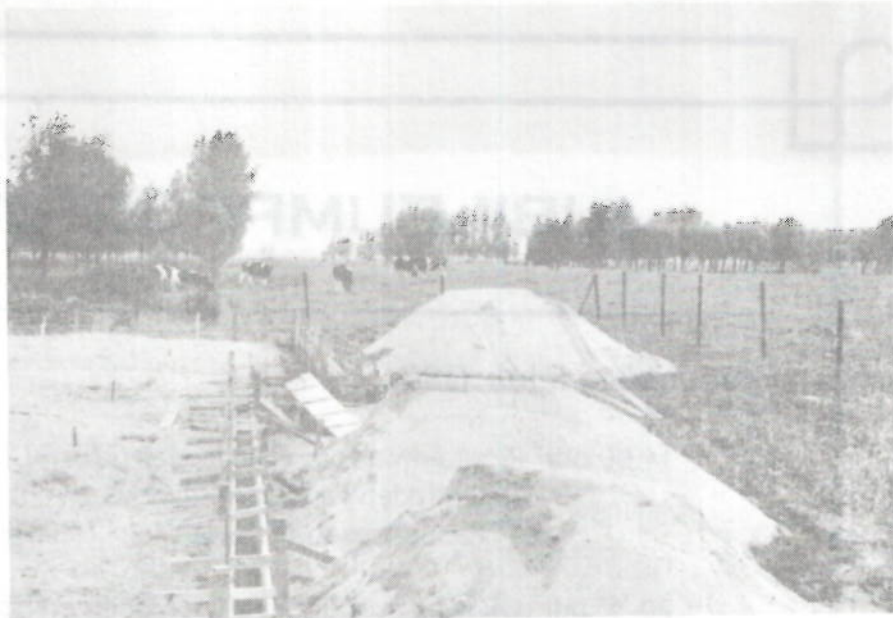
Najaar 1968 de bouw van ons clubhuis aan de Nieuwendijk is begonnen; de aanleg van het terrein moet nog ter hand worden genomen.
